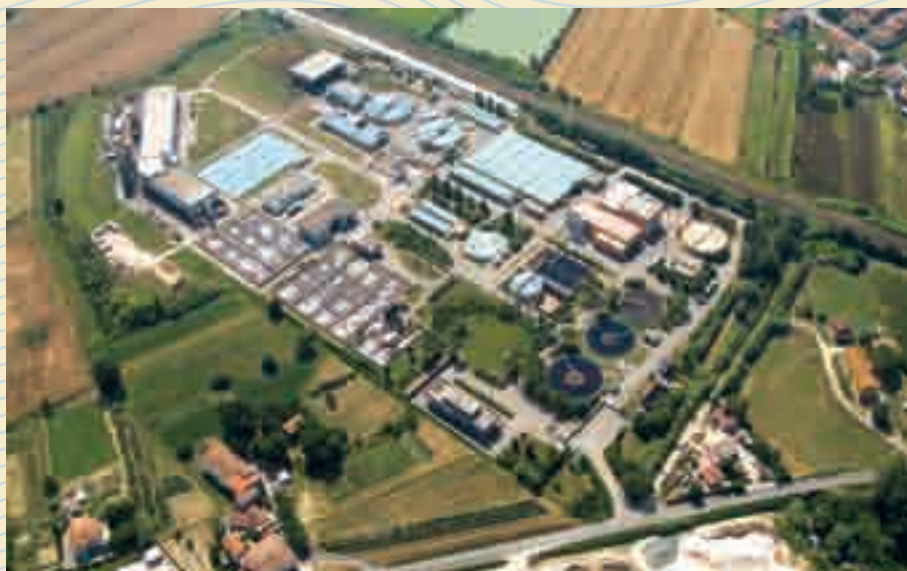
S. Miniato, depuratore zona cuoio.
