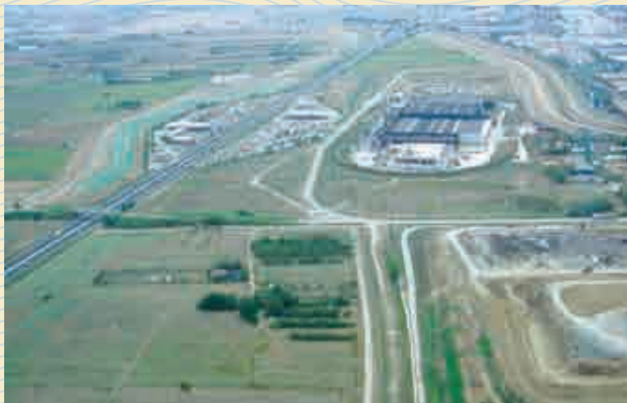
Sesto Fiorentino, Case Passerini, impianto rifiuti Quadrifoglio.
