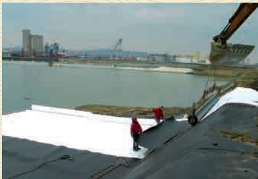
Livorno, escavo bonifica porto.
